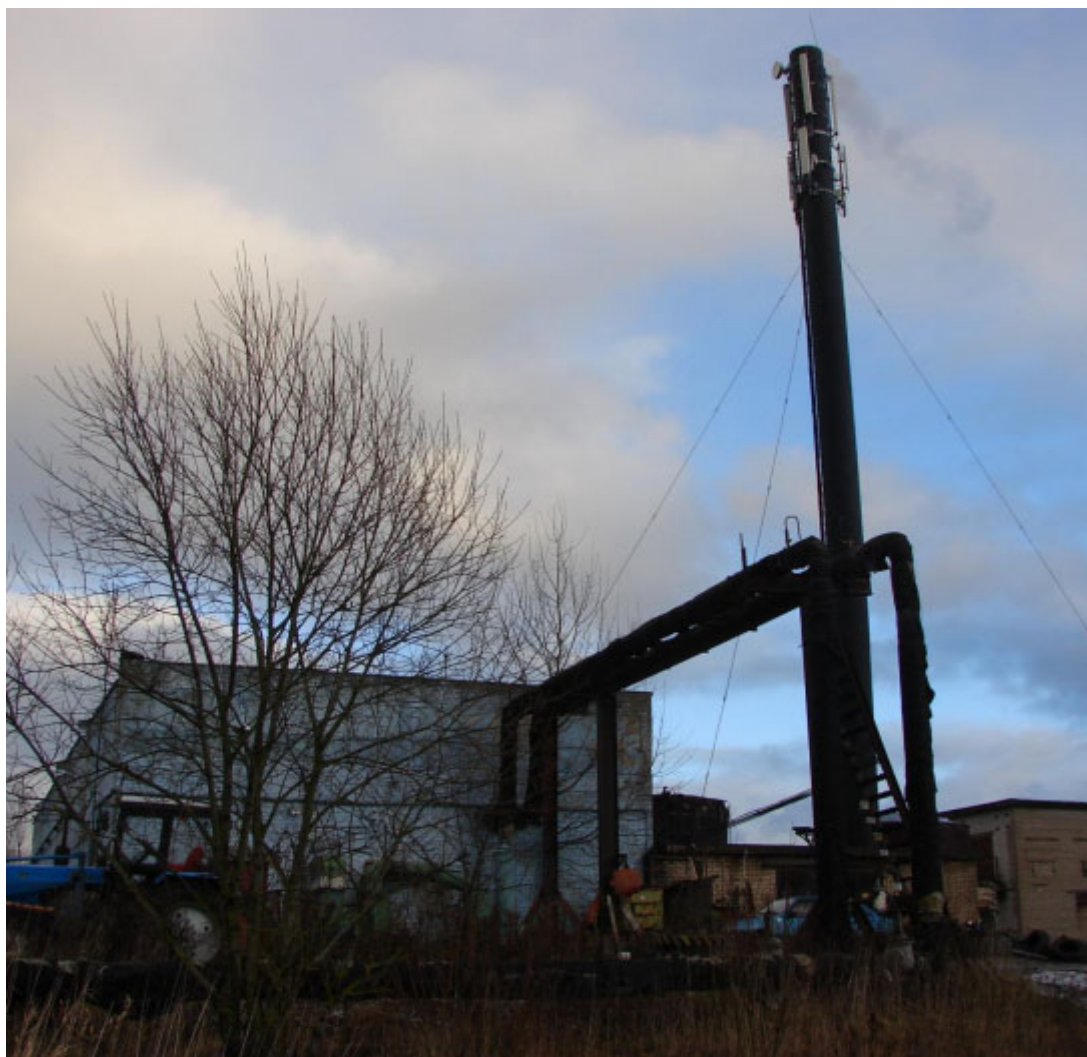
Рисунок 1.2.1. Здание котельной д. Большая Пустомержа
