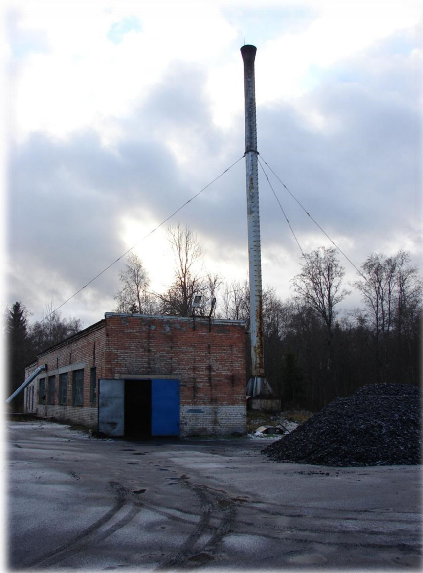
Рисунок 1.2.2. Котельная № 1 (больница) д. Мануйлово
